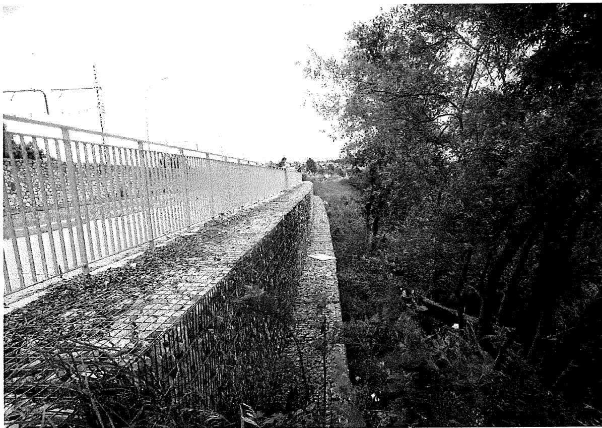
Photo 2 : Renforcement de la berge de la tranche 2 par des gabions
