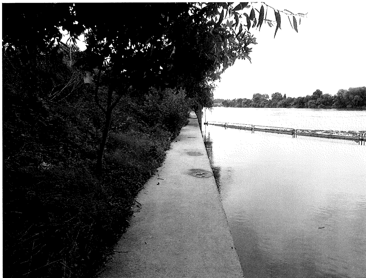
Photo 2 : Contrebas de la tranche 2, berge aménagée
